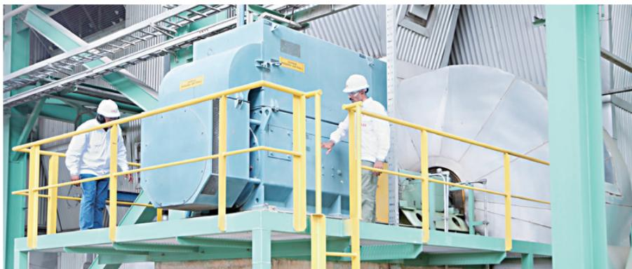
通常情况下，风机会因为较大的叶轮形成较大的转动惯量，因此起动较为缓慢。有些风机会采用关闭风门的方式减小负载转矩进行起动，被称为空载起动，这样可以更简单、快速地起动风机。用ABB软起动器起动风机时，初始起动电压会相对较低，然后逐步升高电压以起动风机。客户可以通过调整软起动器的参数来满足所有的起动工况，既可空载起动，也可满载起动。此外，风机停止时需要很长时间才能静止，而PSTX软起动器的电机制动功能可以使风机快速静止。风机停机时由于风的原因可能会反向旋转，此时可使用静制动功能让风机保持静止。
