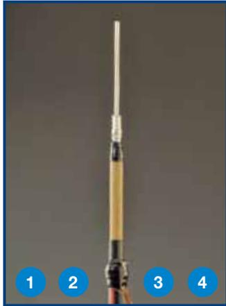
1. 将电缆拉到位然后按所需长度进行切割。按照标准程序，修剪电缆护套、金属屏蔽层，半导体屏蔽和电缆绝缘层，露出导线。
