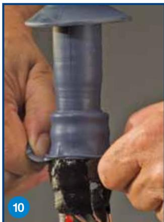
10. 向下折叠边缘直至胶粘剂，密封电缆入口。
