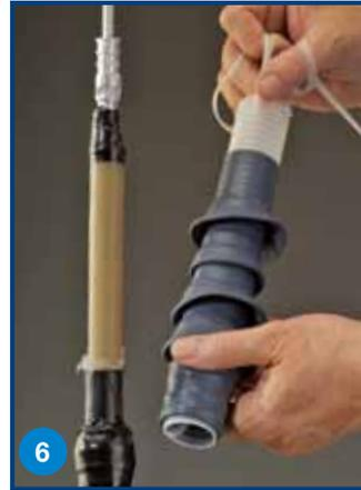
6. 拉出电缆芯线的松头直到芯线与端接器外壳的末端平齐。
