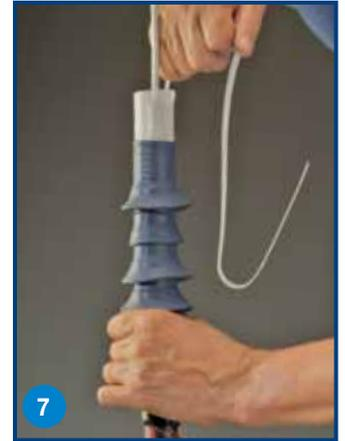
7. 将端接器定位在电缆上。
