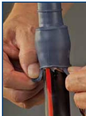
11. 使用硅胶带密封连接器区域的端接器顶部。
