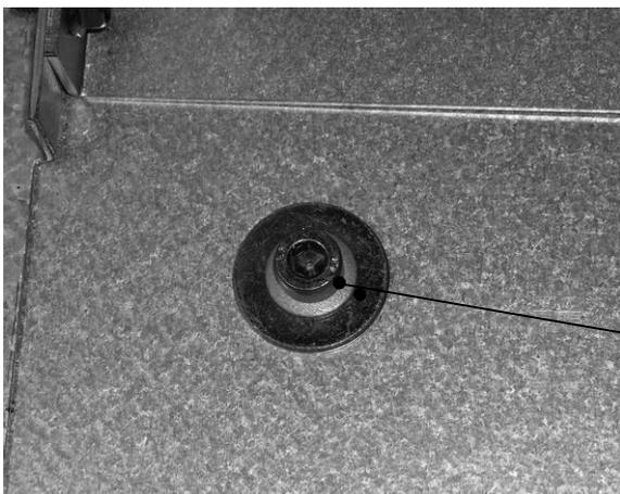
Befestigung des Schaltfeldes mit dem Flureisenrahmen
