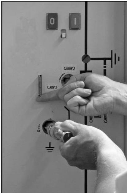
Abb. 4.2.2.5: Betätigung der Erdungsschalter
