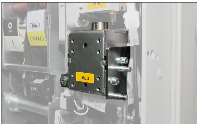
Le déclencheur à minimum de tension réalise l'ouverture du disjoncteur en cas de baisse sensible ou absence de tension d'alimentation sur celui-ci. Il permet la fermeture du disjoncteur seulement quand le déclencheur est alimenté (le verrouillage de la fermeture est mécanique).
