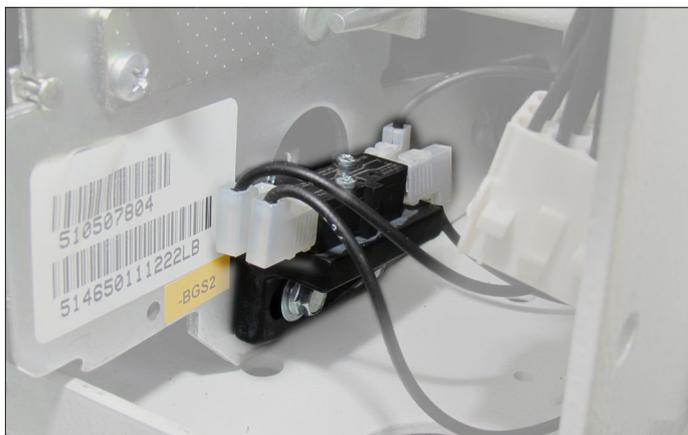
Il est constitué d'un micro-contact qui permet la signalisation à distance de l'état du ressort de fermeture de la commande du disjoncteur.
