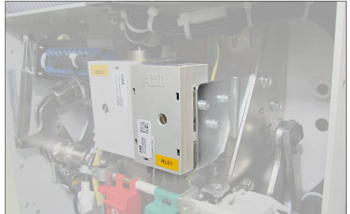
Permet d'actionner la commande seulement avec l'électro-aimant alimenté. L'électroaimant de verrouillage dans la commande a les mêmes caractéristiques électriques du déclencheur de fermeture -MBC.
