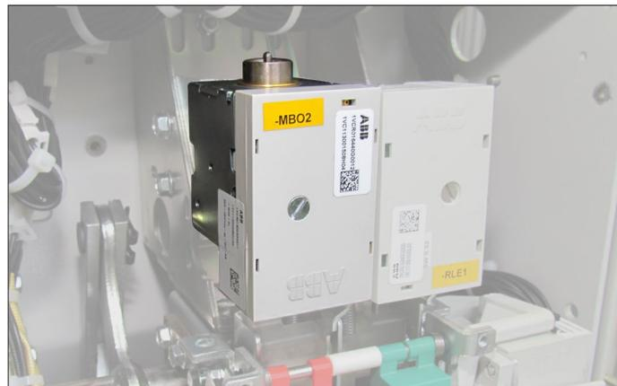
Comme le déclencheur d'ouverture -MBO1, il permet la commande d'ouverture de l'appareil à distance ; il peut être alimenté par le même circuit du déclencheur d'ouverture principal -MBO1 ou par un circuit complètement séparé du déclencheur -MBO1.
