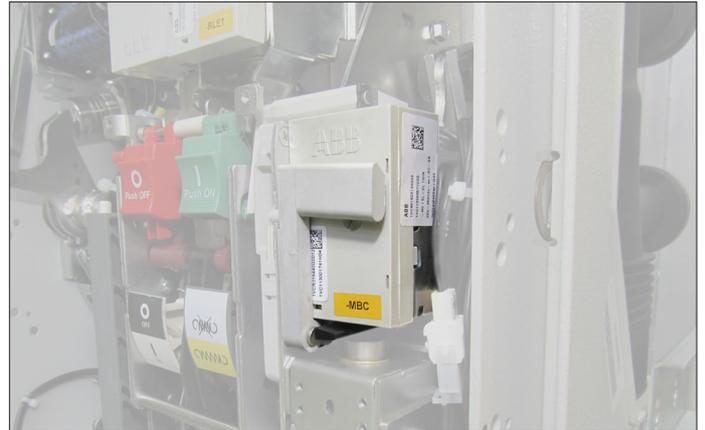
Permet la commande de fermeture à distance de l'appareil. Ce déclencheur est indiqué tant pour le service instantané que pour le service continu ; il n'est pas prévu qu'un contact auxiliaire le désalimente une fois que l'ouverture du disjoncteur s'est produite.
