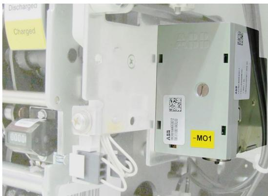
qu'un contact auxiliaire désalimente le déclencheur d'ouverture quand le disjoncteur est ouvert. Pour garantir le déclenchement, la durée minimum de l'impulsion de courant doit être de 100 ms. Le contrôle du fonctionnement et de la continuité du déclencheur est possible avec le dispositif STU (accessoire 15 en option), ou avec des dispositifs intégrant les fonctionnalités CCC (Control Coil Continuity) ou TCS (Trip Coil Supervision).
