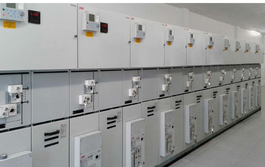
La solution LC1000 pour tableaux UniSec, développée pour les tableaux de moyenne tension, détecte et isole les défauts dans les réseaux en boucle en moins de 1 seconde, en garantissant la fonctionnalité totale du réseau et en réduisant au minimum le temps de hors service.
