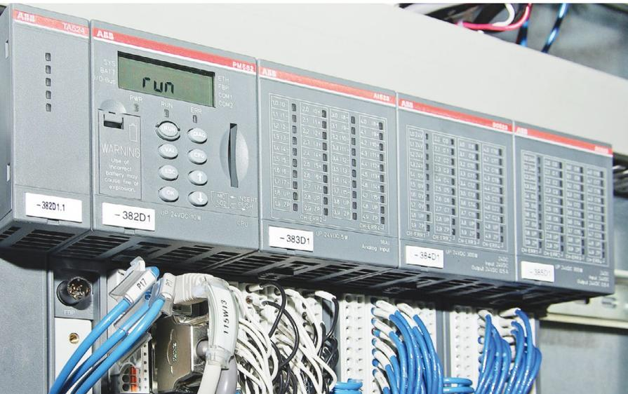
MPS Press Control ist das Steuerungssystem von ABB für alle Arten von Zeitungsdruckmaschinen. Die Funktionalität des Systems ist auf die Druckmaschine zugeschnitten und eignet sich sowohl für neue als auch für die Nachrüstung und Erweiterung vorhandener Druckmaschinen.
