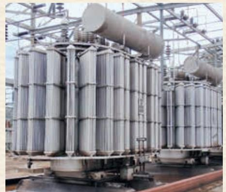
Les trois transformateurs élévateurs BBC de 9 MVA 22/66 kV, datant de 1914.
