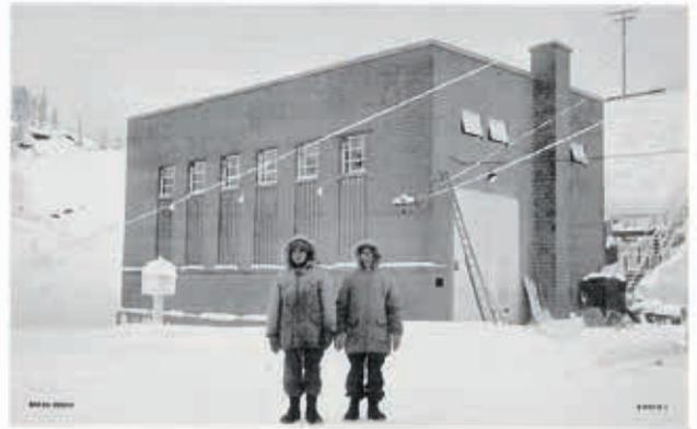
**Fig. 26.** — La centrale de Snow River alimente Yellow Knife, la ville des chercheurs d'or, par l'intermédiaire d'une ligne à 115 kV longue de 110 km. C'est uniquement par la liaison THF utilisant cette ligne que le personnel sédentaire de l'usine communique avec le reste du monde.
