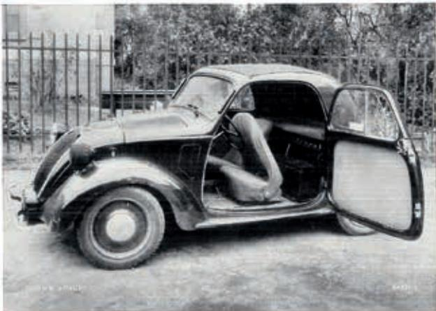
Fig. 166. -- Automobile Fiat 500 (Topolino) transformée pour la traction électrique. Puissance 4,2 ch. Batterie au plomb de 90 Ah (pour une décharge en 10 h), 84 V. Vue montrant le montage de la batterie. Convient pour la circulation dans les villes relativement plates. Vitesse maximum en palier 60 km/h.
