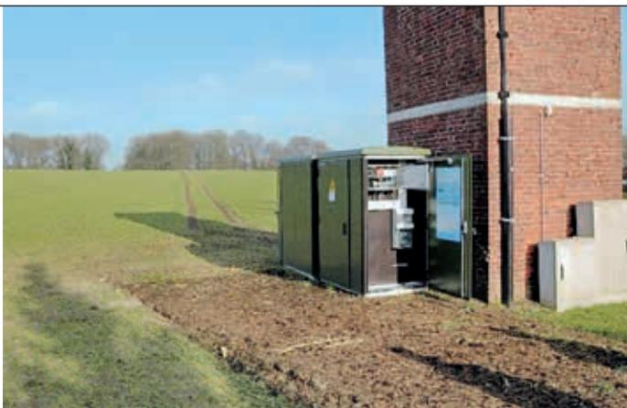
4b Schranklösung mit neuer Schaltanlage und zusätzlicher „Intelligenz“ für bestehende Ortsnetzstationen
