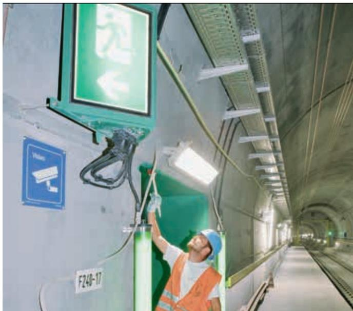
Gesucht war ein flexibles, leicht zu installierendes und vollständig geschlossenes Kabelschutzsystem, das den Bedingungen im Tunnel standhalten konnte.
