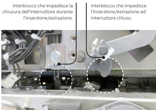
Interblocco che impedisce la chiusura dell'interruttore durante l'inserzione/estrazione.
