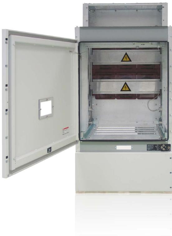
La classe PM è la scelta ottimale per la sicurezza del personale che si trovi ad operare nel compartimento garantendo in modo omogeneo la messa a terra della struttura; nella fotografia la soluzione PowerCube dove si notano gli otturatori metallici chiusi ad interruttore estratto e collegati alla struttura del compartimento interruttore.
