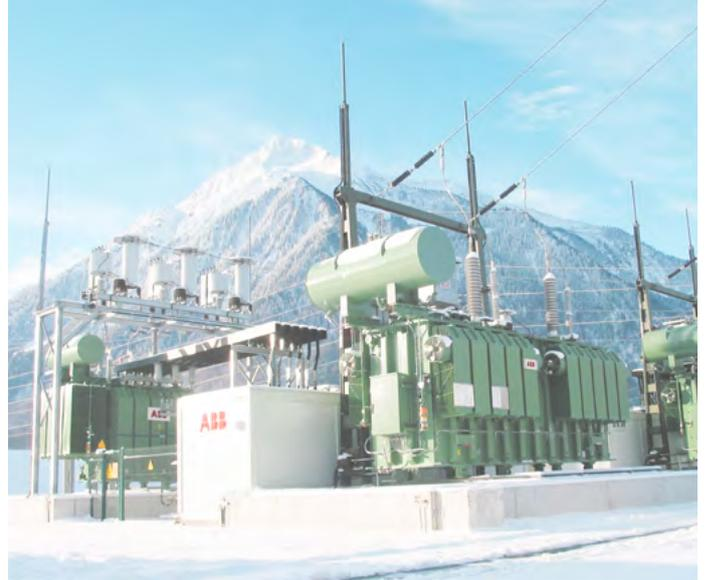
Der PCS 6000 Rail ist ein leistungsfähiges Umrichtersystem, das speziell entwickelt wurde, um das Bahnstromversorgungsnetz mit 16.7 Hz oder jeder anderen Frequenz mit dem Landesnetz zu koppeln.
