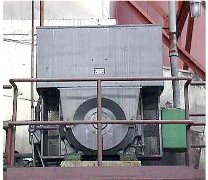
Der 20 Jahre alte und ursprünglich für den Betrieb mit Festdrehzahl vorgesehene Gebläsemotor arbeitet am ACS 1000 mit deutlich höherem Wirkungsgrad und niedrigerem Geräuschpegel
